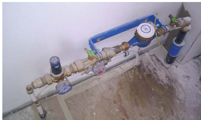
Il dumbrader d'aua vegn montaus leu nua che la lingia principala vegn en casa (avon l'installaziun da repartiziun dall'aua). Ei vegn differenziau denter dumbraders horizontalis e verticalis.
